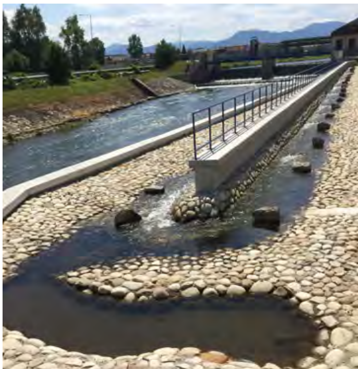
Spriechodnenie migračnej bariéry na existujúcej hati na toku Turiec v meste Martin vybudovaním nového rybovodu a zabezpečenie pozdĺžnej kontinuity vodného toku
