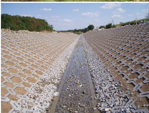
Betónové prefabrikáty – trávovo-betónové opevnenie brehov vodných tokov
