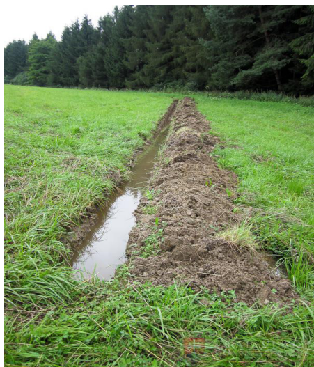
Infiltračná priekopa bezprostredne po realizácii
