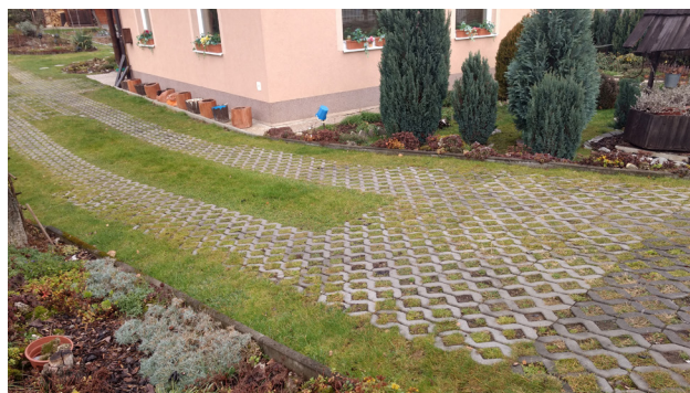
Zatravnňovacia dlažba na príjazdovej ceste k rodinnému domu
