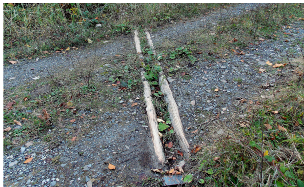
Znefunkčnená (nevyčistená) odrážka z guliačov
